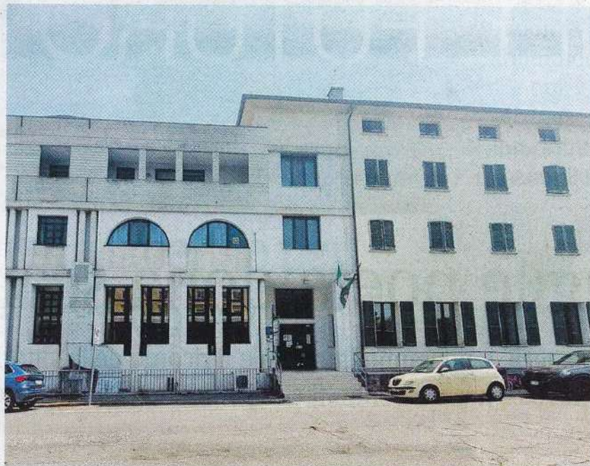
La struttura della Casa di riposo di Manerbio che sarà protagonista di una grandissima opera de restyling
